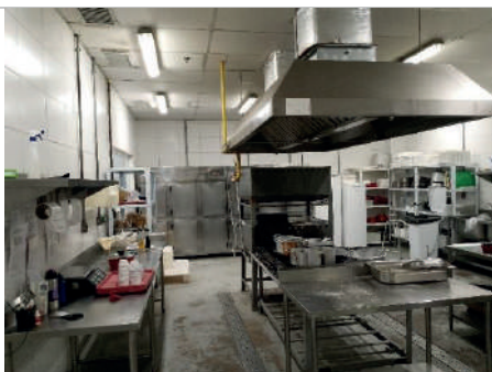
Cozinha ao lado do refeitório
