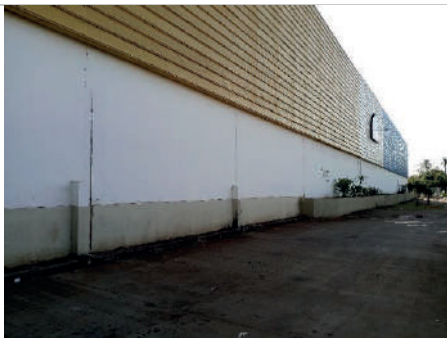
Fachada da Av. Fábio Barreto
