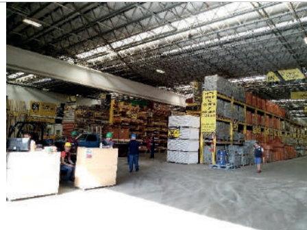
Vista parcial do Bloco 3
