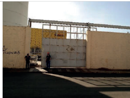
Portão de acesso pela Rua Castro Alves
