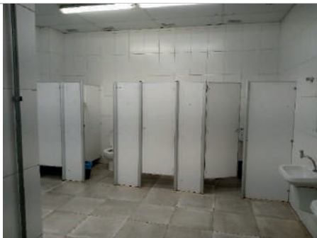
Banheiro aos funcionários no mezanino
