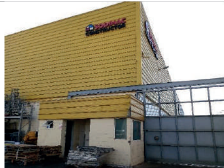
Vista parcial da fachada
