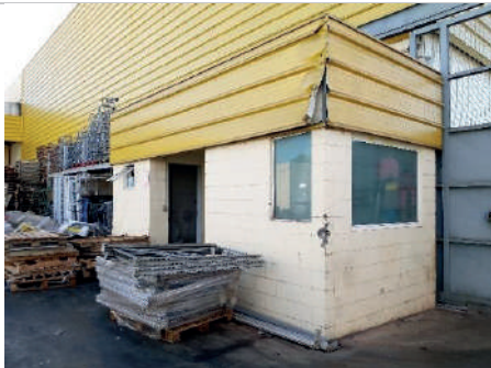
Banheiro e depósito
