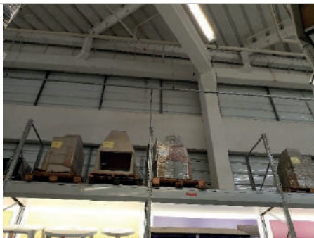
Detalhes da estrutura em pré-moldado
